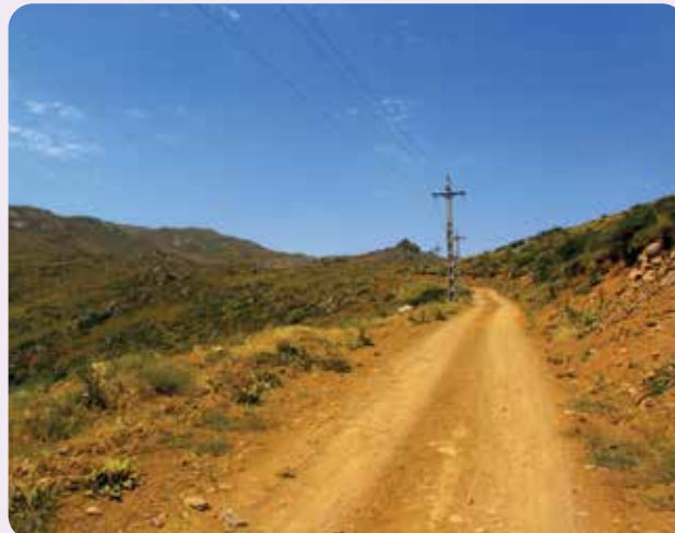
شکل ۱۹- نمایی دیگر از برق‌کشی و احداث جاده در مراتع طارم سفلی (شکل اصلی)
