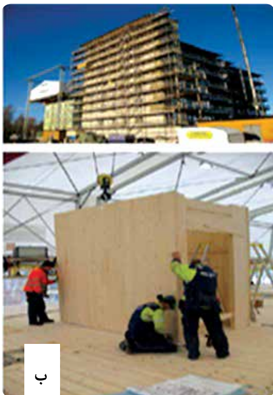
شکل ۲- استفاده از فرآورده‌های لایه‌ای متقاطع CLT (الف) و گلولم (ب) در ساخت‌وساز
