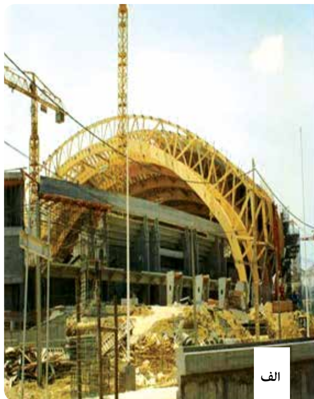
شکل ۲- استفاده از فرآورده‌های لایه‌ای متقاطع CLT (الف) و گلولم (ب) در ساخت‌وساز
