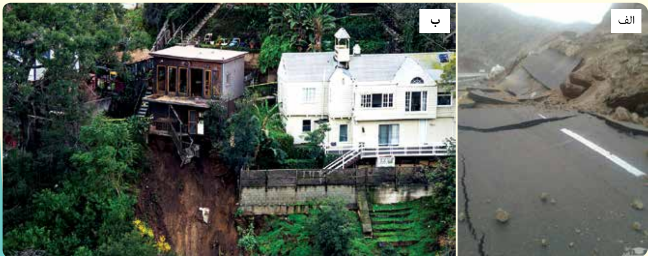
شکل ۳- رانش در الف) دامنه‌های طبیعی شیب‌دار و تخریب جاده در منطقه کن و سولوق در استان تهران و ب) حاشیه مسیل‌ها و در نزدیکی پی ساختمان (برگرفته از اینترنت)
