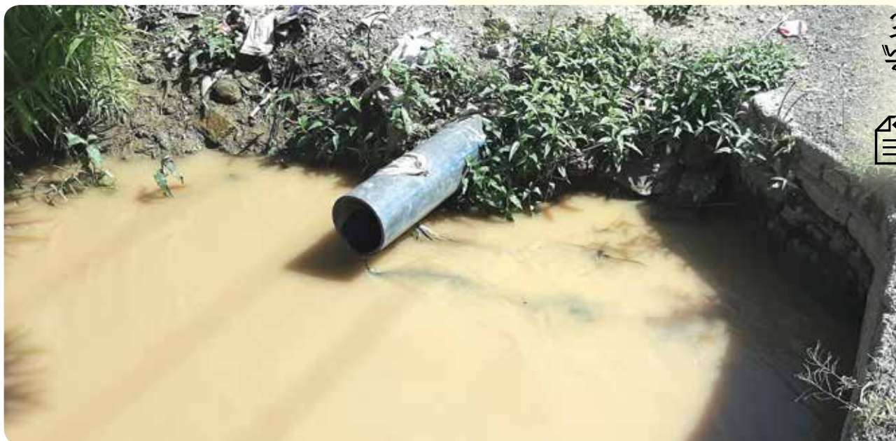
شکل ۴- ورود فاضلاب کارگاهی به کانال آبیاری
