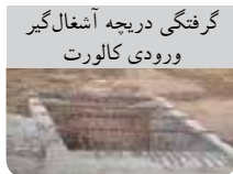
سرریز سیلاب از محل حوضچه آرامش (ورودی کالورت)
