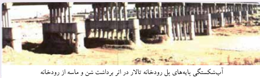
نمایی از گودال ناشی از برداشت شن و ماسه در رودخانه تالار
