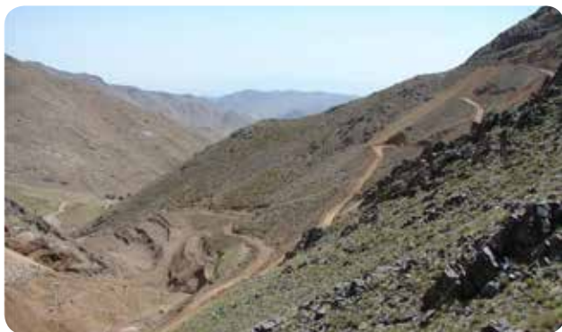
شکل ۶- احداث جاده دسترسی در اراضی شیب‌دار ارتفاعات قرآن
