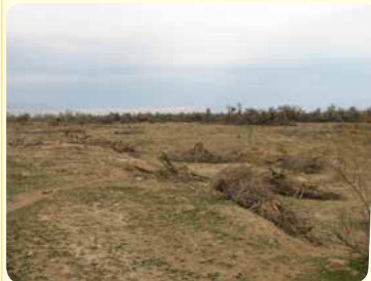
شکل ۱۱- کف بردن جنگل کران رودی برای ساخت مسیر انحرافی رودخانه توسط سازمان آب و برق خوزستان (حاشیه رودخانه کارون، منطقه عقیلی، گتوند، ۱۳۸۷/۱۰/۲۳)
