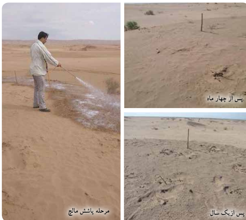
شکل ۱۳- مراحل مختلف پاشش مالچ اکریلیکی و استقرار آن در تپه‌های ماسه‌ای کاشان
