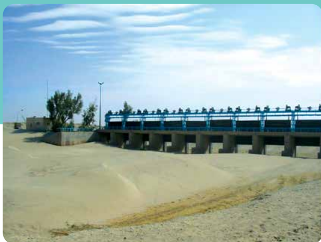
شکل ۹- حرکت تپه ماسه بادی فعال روی اراضی کشاورزی جزینک و تجمع رسوبات پشت سد تنظیمی زهک
