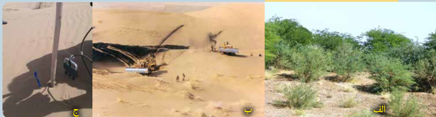
شکل ۱- نحوه مالچ‌پاشی نفتی و تثبیت بیولوژیک ماسه‌زار الف: ماسه‌زار بعد از تثبیت با Acacia Victoria ، ب: مالچ‌پاشی با مالچ نفتی، ج: اندازه‌گیری رطوبت در ماسه‌زار شاهد
